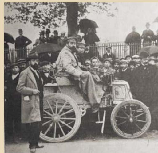
*In questa immagine si può notare che, per l'ultima volta in corsa, il vincitore De Knyff guidava una Panhard & Levassor equipaggiata con una barra di direzione o 'queue de vache' (=letteralmente 'coda di mucca') e non ancora con un volante.*
