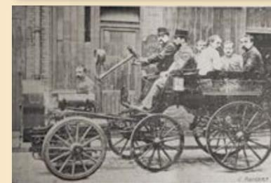
*Si distinguono chiaramente le stanghe che poggiano sulle due ruote dell'attacco-motore Amiot-Péneau.*
