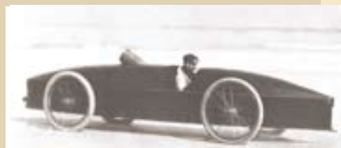
1906: L’eccezione ‘Vapore’ la Stanley raggiunge 200 km/h.
